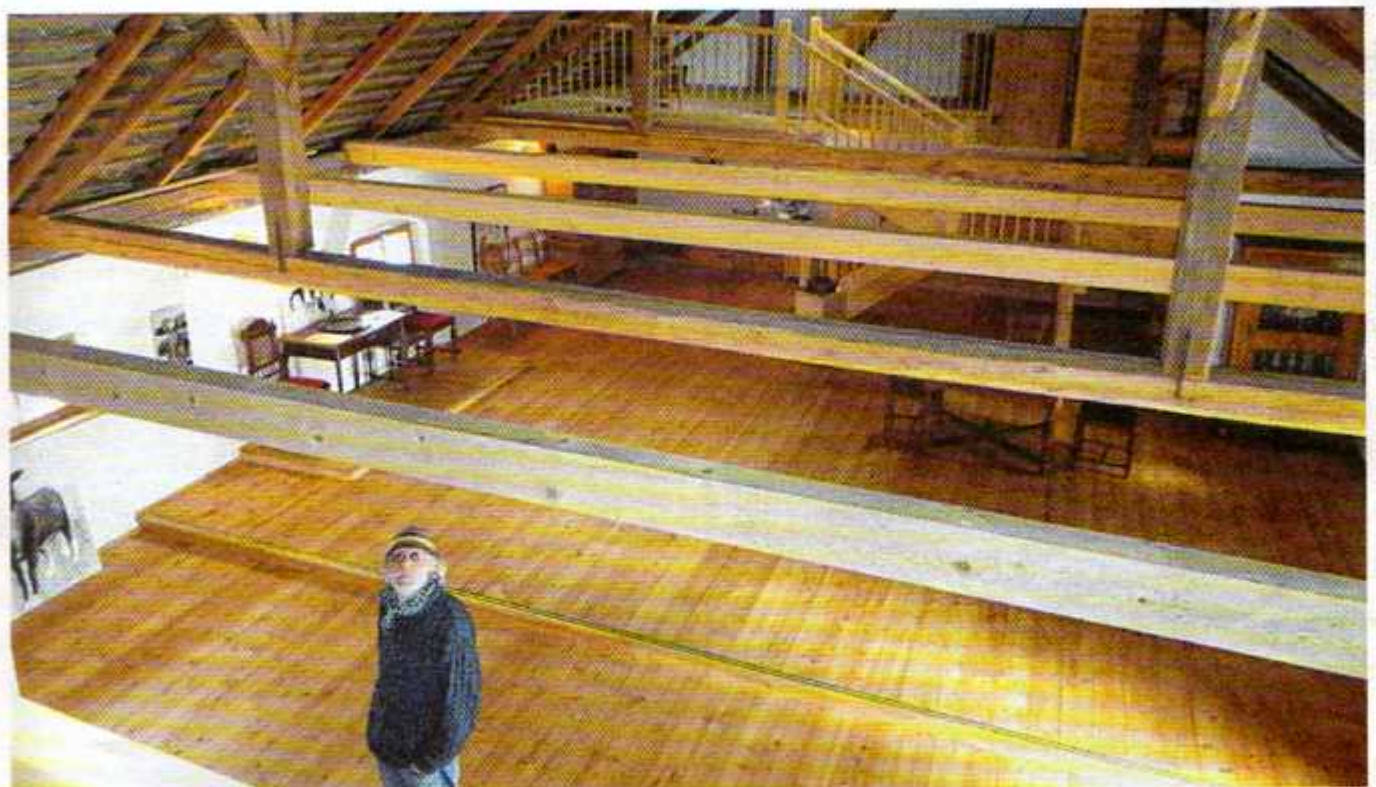
Auch der frühere Stadl der Landwirtschaft wurde top-saniert.
